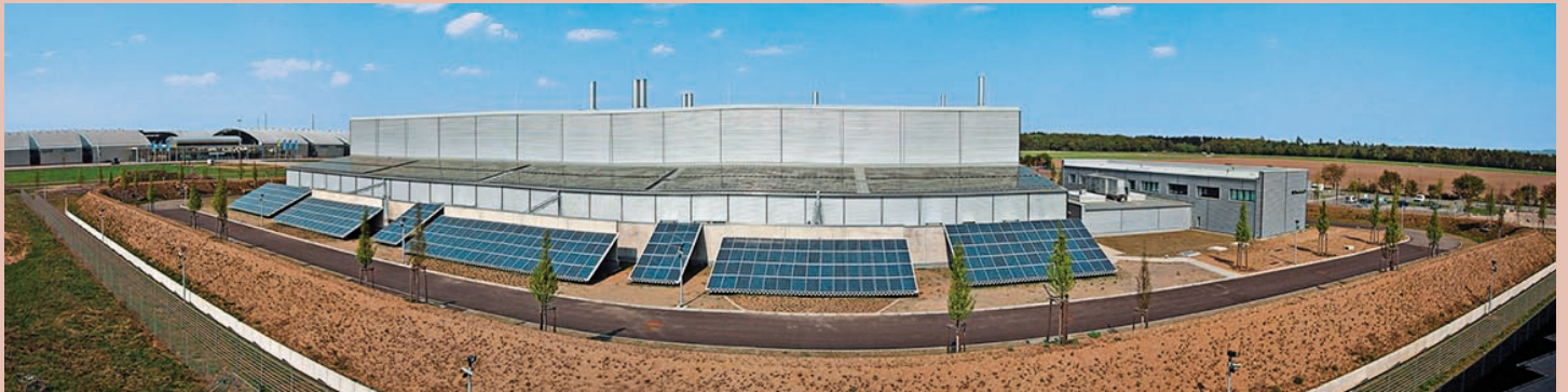
Abbildung 2: Eines der modernsten Rechenzentren Europas – Das Rechenzentrum der Fiducia in Rheinstetten
